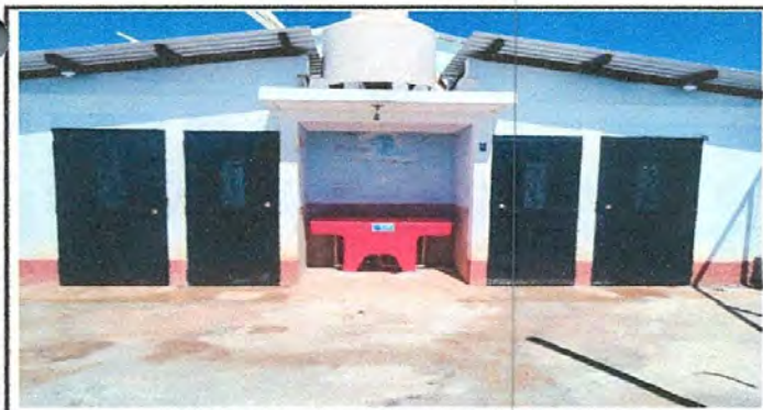
Foto 5: Sustitución de puerta en servicios sanitarios
