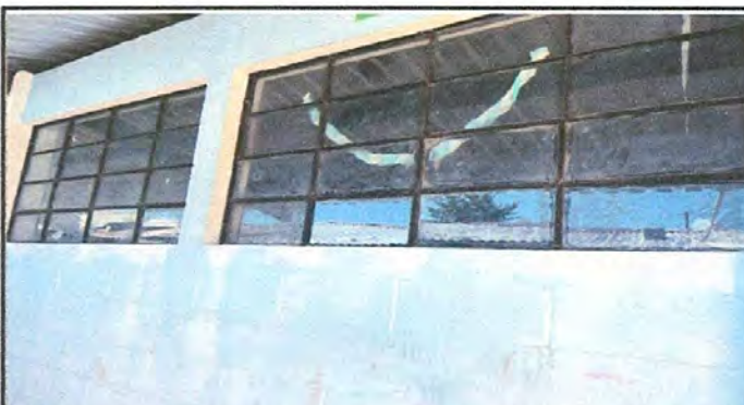
Foto 4: Sustitución de Vidrios
