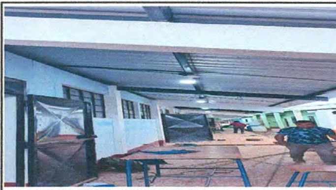
Foto 2: Reparación de sistema eléctrico
