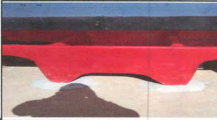
Foto1: Sustitución de Pila plástica de dos lavaderos
