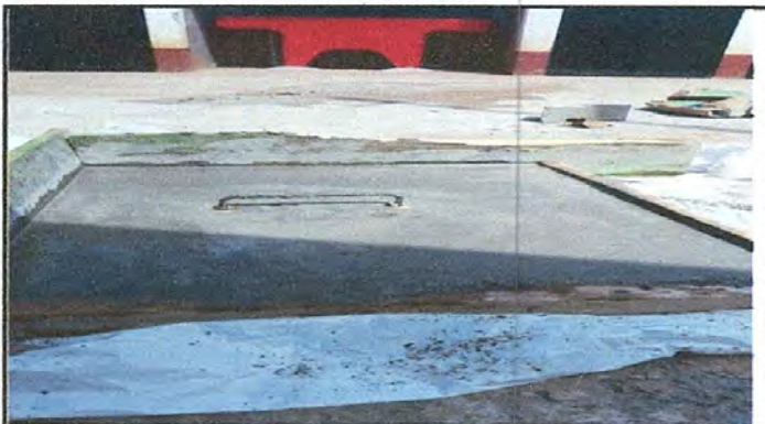
Foto 3: Mantenimiento y reparación de fosa séptica
