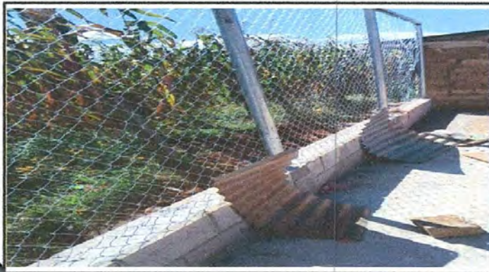
Foto 1: Reparación de muro perimetral de block con tubo y malla galvanizada
