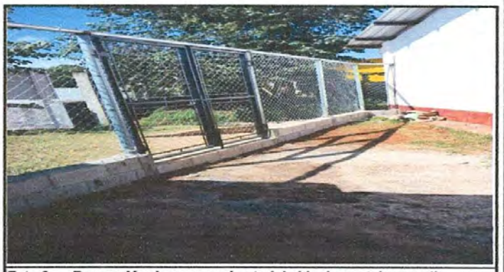
Foto 6: Reparación de muro perimetral de block con tubo y malla galvanizada
